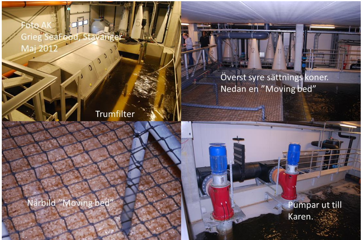
Figur A1.4 RAS anläggning i realiteten, från Grieg Seafood, Stavanger.
